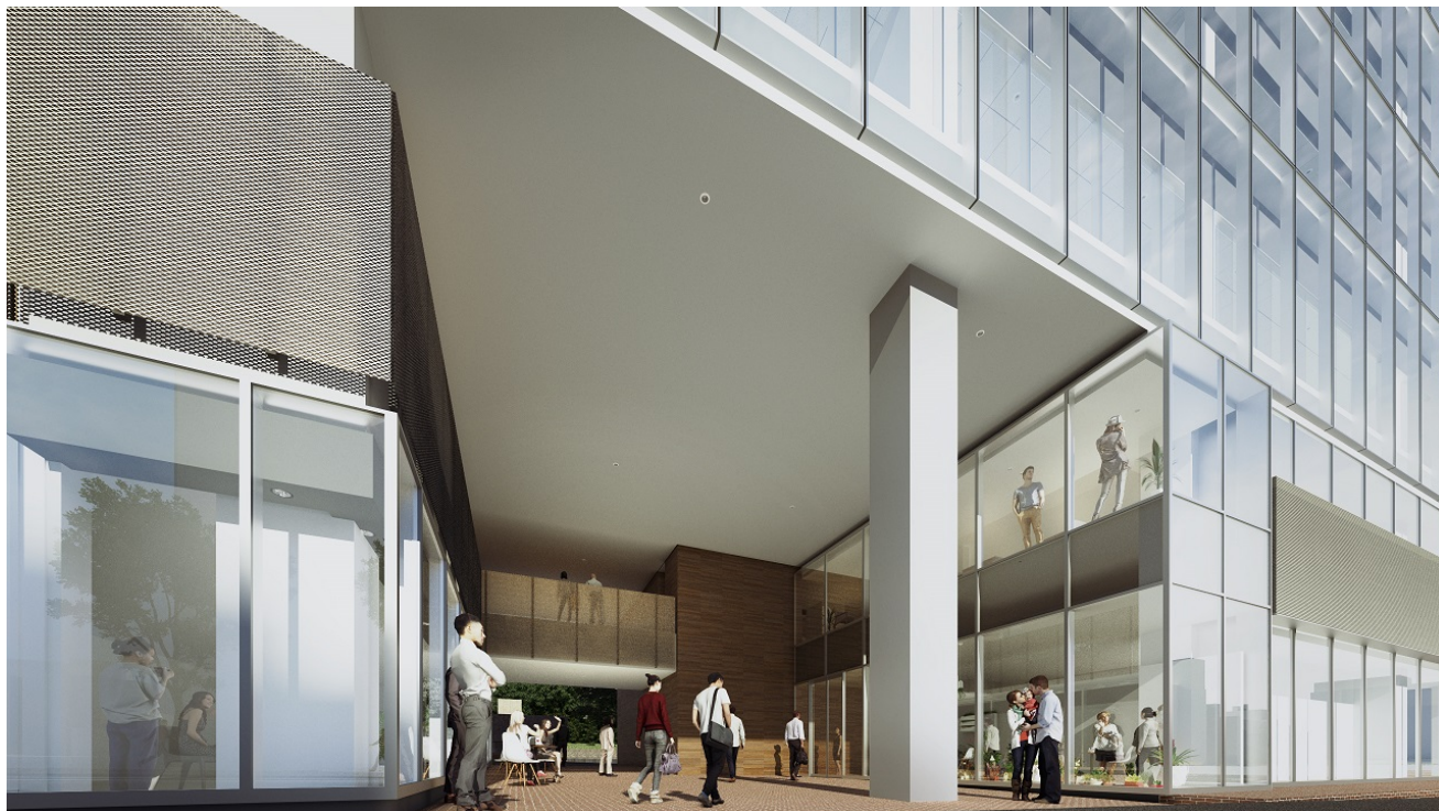
二層吹き抜け貫通通路(1階)
